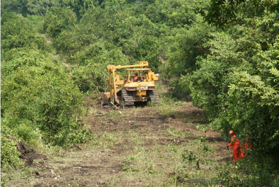
Los naranjales son derribados para perforar pozos.
